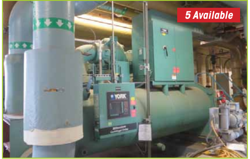
YORKYK GD GB H7 - CVE INDUSTRIAL CENTRIFUGAL CHILLER, 800 TON
